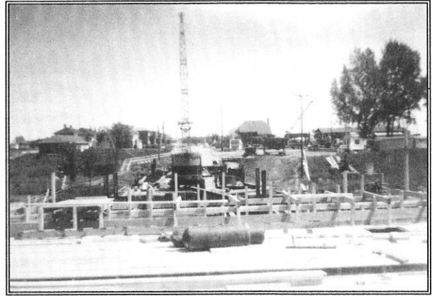
Construction du pont Barrette en 1959 (À l'arrière, la passerelle pour les piétons)
