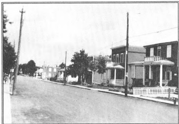
C'était la rue du Pont. Elle a été la rue Saint-Paul avant de devenir la 8 e Rue
